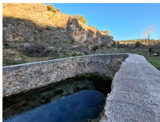
Figura 2. Surgencia kárstica del manantial de la Fuente Fresnera que sirve de abastecimiento a la población y al regadío de la reconocida Huerta de Caballar.
